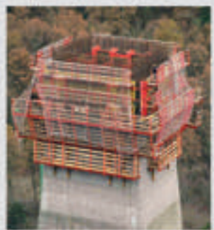
Viaducto de Montabiz, Cantabria
