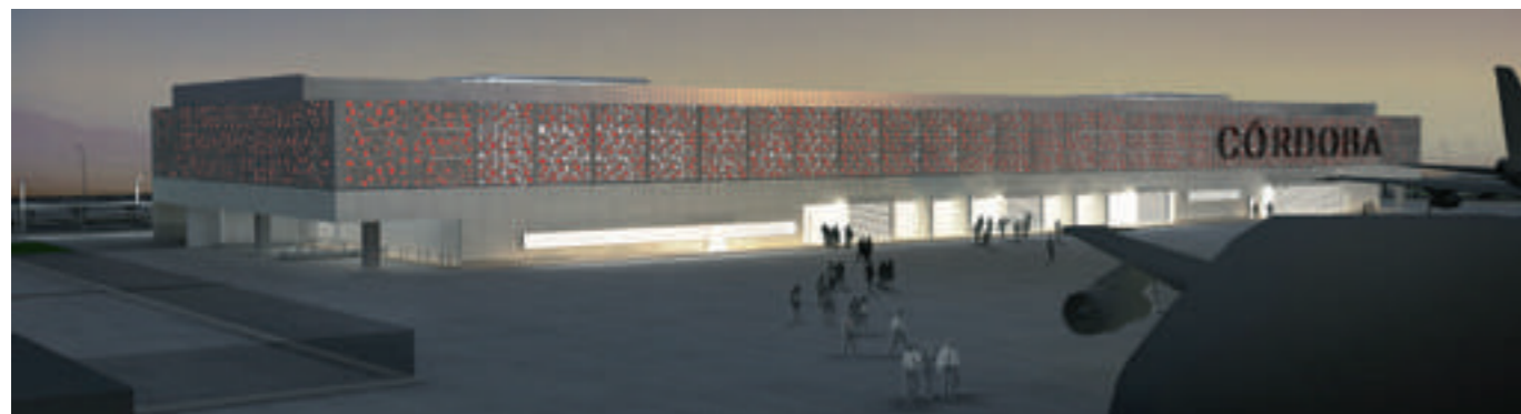
Aeropuerto de Córdoba Infografía.
