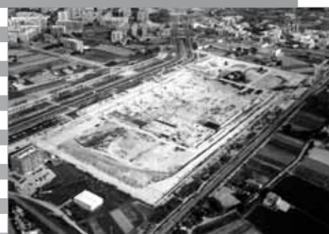
Proceso de construcción
