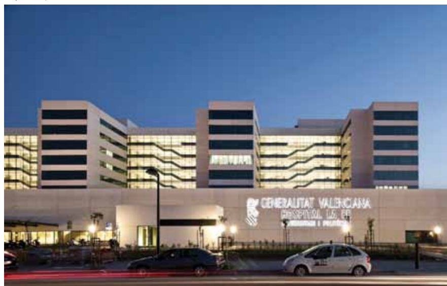
Hospital La Fe, Valencia. Foto: Pablo Casares
