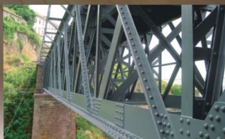
Protección para Estructuras Metálicas
