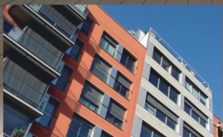
Protección y Decoración de Fachadas
